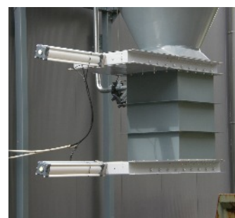
Spjældsystem for materialeudladning
