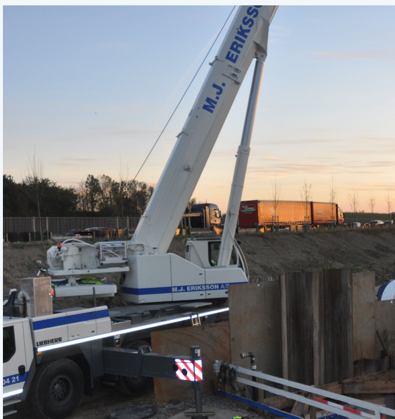
Hele entreprisen med tunnelering kan foretages, mens motorvejen er i drift.
