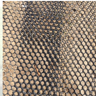
Nettet, der leveres i ruller á 2 m bredde, rulles ud med et overlap på ca. 15 cm.
