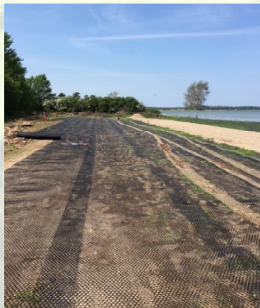
Til sidst blev der udrullet plast armeringsnet i begge sider af vejen.
