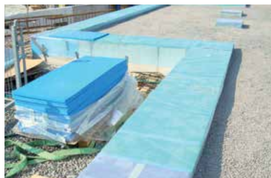
En “fjädrande bädd” installerad på groundsulor vid kv Traversen
