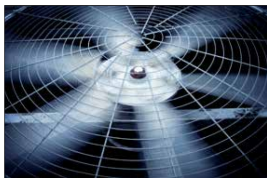
Vibrationer och stömljud skapas av både roterande delar och pulserande drift
