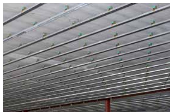
AMC Mecanocaucho® Sylomer-hängare installeras enkelt och snabbt
