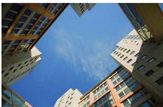
Allt fler tak utnyttjas som t.ex. terrasser, vilket ställer högre krav på att skydda de vattentäta skikten
