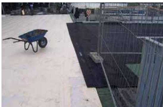
Kraitec Top är en skyddsmatta för platta tak och byggnads-konstruktioner
