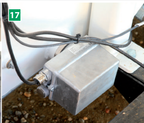
17 Vandvarmer (ekstraudstyr) Elektrisk opvarmning af vandbeholderen til frostbeskyttelse. Komplet med termostat og afbryder. Varmelegemet er normalt tilsluttet til styringen for automatisk drift og frostbeskyttelse. Effekt 4 kW. Spænding 3 x 400 volt.
