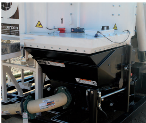
13 Betonpumpe (ekstraudstyr) Hydraulisk stempelpumpe til beton. Kan leveres i forskellige størrelser. Med indikator for når beholderen er fyldt, sikkerhedslåg og suikkerhedsafbryder. Beholderen indeholder max 400 liter. Kapacitet 10 m 3 /time.
