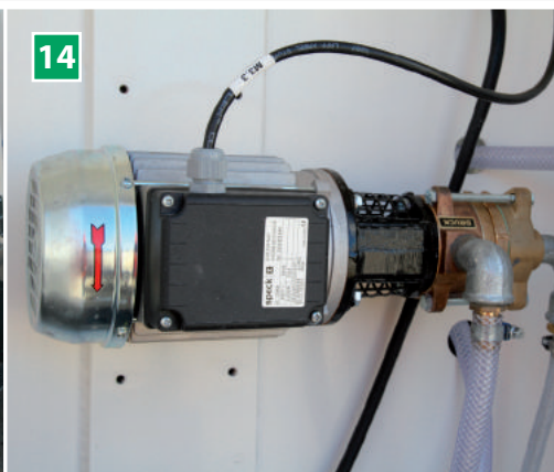
14 Kemipumpe (ekstraudstyr) Højkvalitets tidsbaseret doseringspumpe 0,25 kW til forskellige kemiske tilsætningsvæker, med 3/8" sugeslange, kontraventil og filter i rustfrit stål. Mulighed for installation af 1 - 4 kemipumper.
