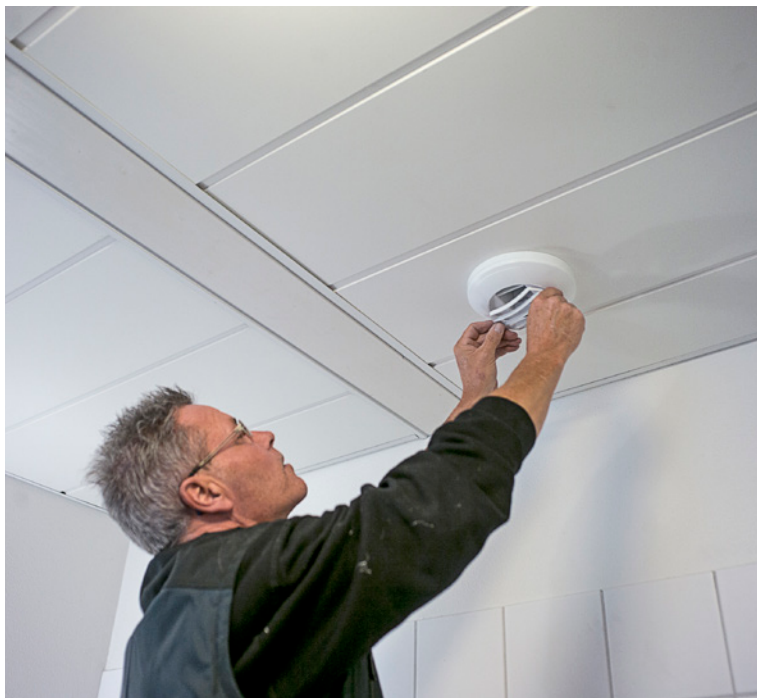
Neotherm ventiler i plejeboligen åbner og lukker for ventilationen efter behov.
