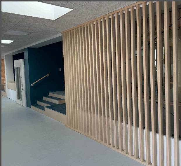
Krydsfinér Lameller samt Trappeinddækning
