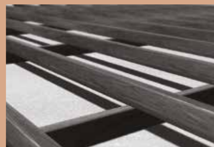
1.2 Korrekt strøafstand
