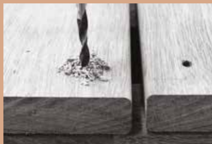
6. Forboring af huller
