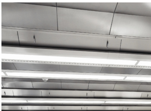
Snit i et dobbelt køkkenventilationsloftsplenum med Water Wash teknologi (KCW).
