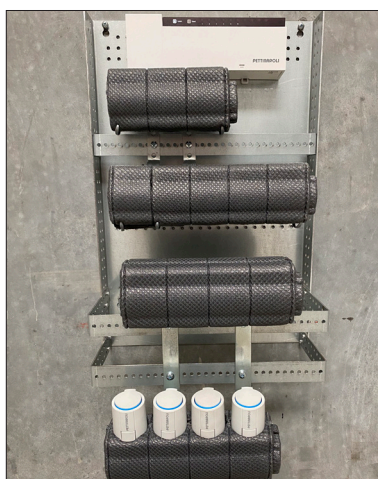
Skaktløsning med ekstra tilbehør: gulvvarmestyring og telestater.
