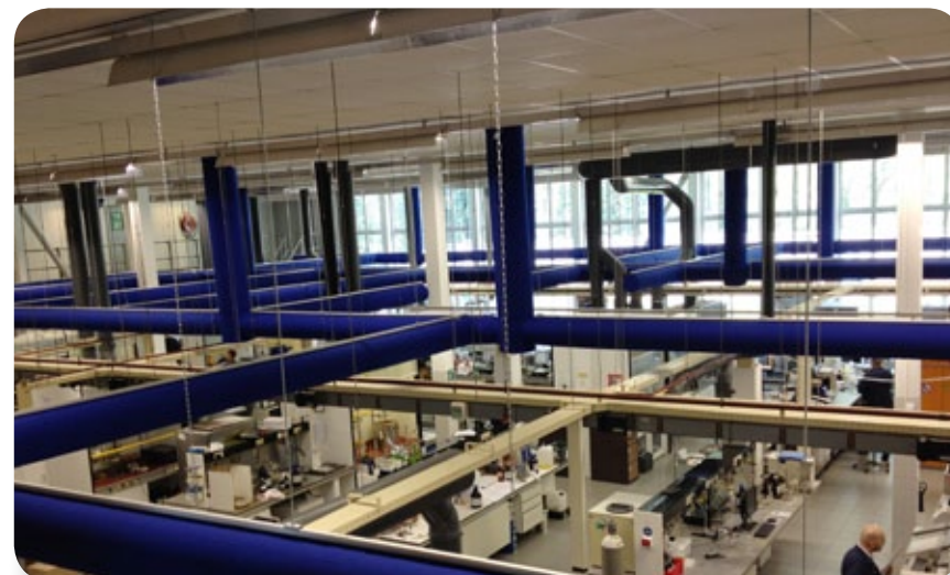
KE Hybrid (Low Inject) Ø400 og Ø300 mm tekstilkanaler
