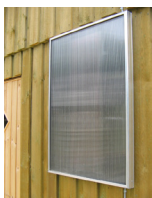
Solarluftkollektor an der Außenwand eines Ferienhauses
