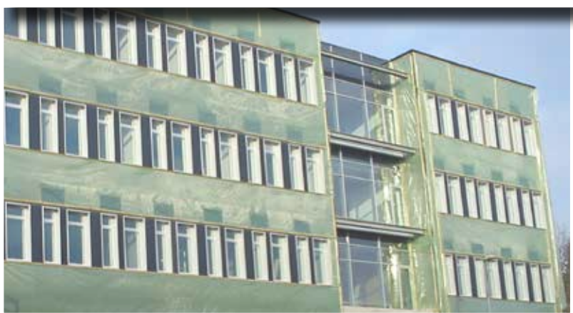
Den færdige Gyproc THERMOOnomic bagvæg inden montage af solcellepaneler.
