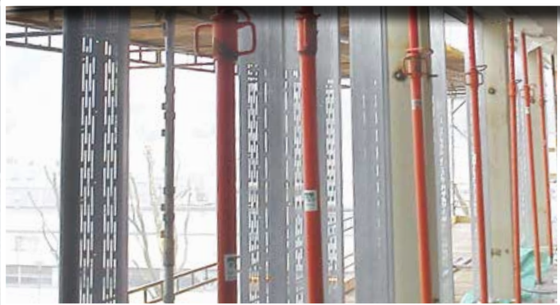
Gyproc THERMOmic-profiler er monteret.
