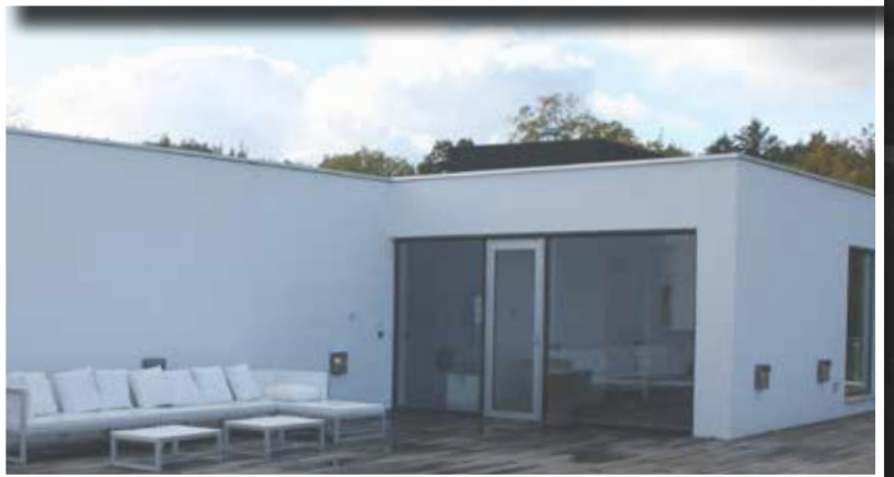
Den færdige facade med pudset overflade.
