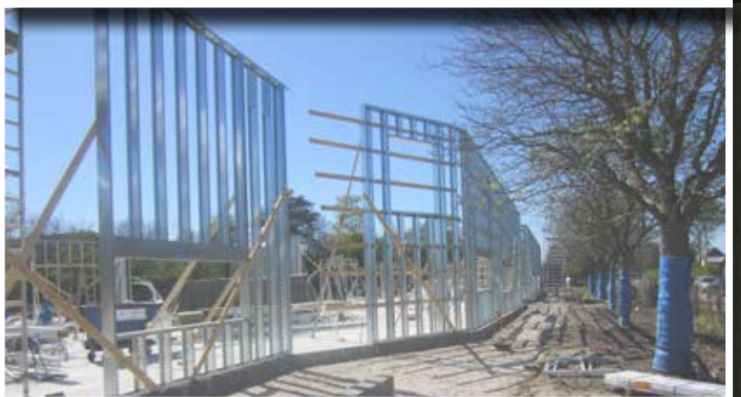
De første Gyproc THERMOmatic-profiler er rejst.
