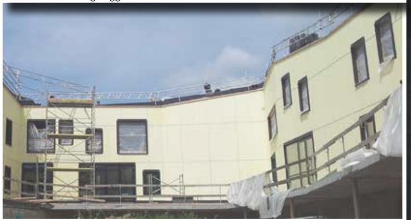
Glasroc H Storm Vindspærreplade er færdigmonteret på Gyproc THERMOconomic bagvæggen.
