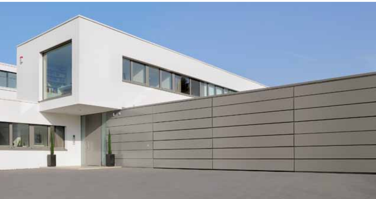
Beklædning fra bygherrens side med aluminium-sandwichplader
