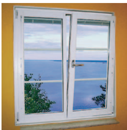
B – Dreje/kip under ventilation.
