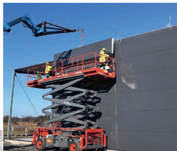
Smidigt montage av sandwichväggar.
