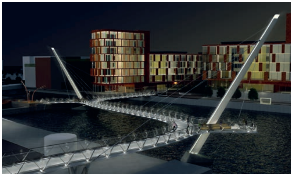
Bild 4. Ljussättningen av brobanan sker från punktbelysning i handledarna, men effektbelysning ska installeras både vid foten och i toppen av respektive pylon. Dessutom finns slitsar i pylonens alla hörn, i vilka längsgående ljuslister kommer att placeras och på toppen av pylonerna står akrylkupoler som ska lysas upp av två armaturer från insidan.
