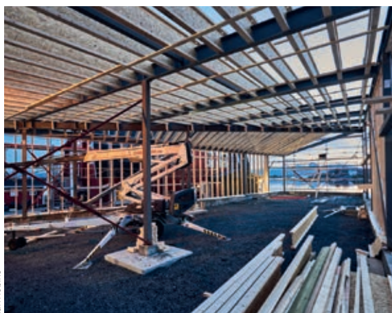
Restaurantbygget med samvirke av tre og stål.
