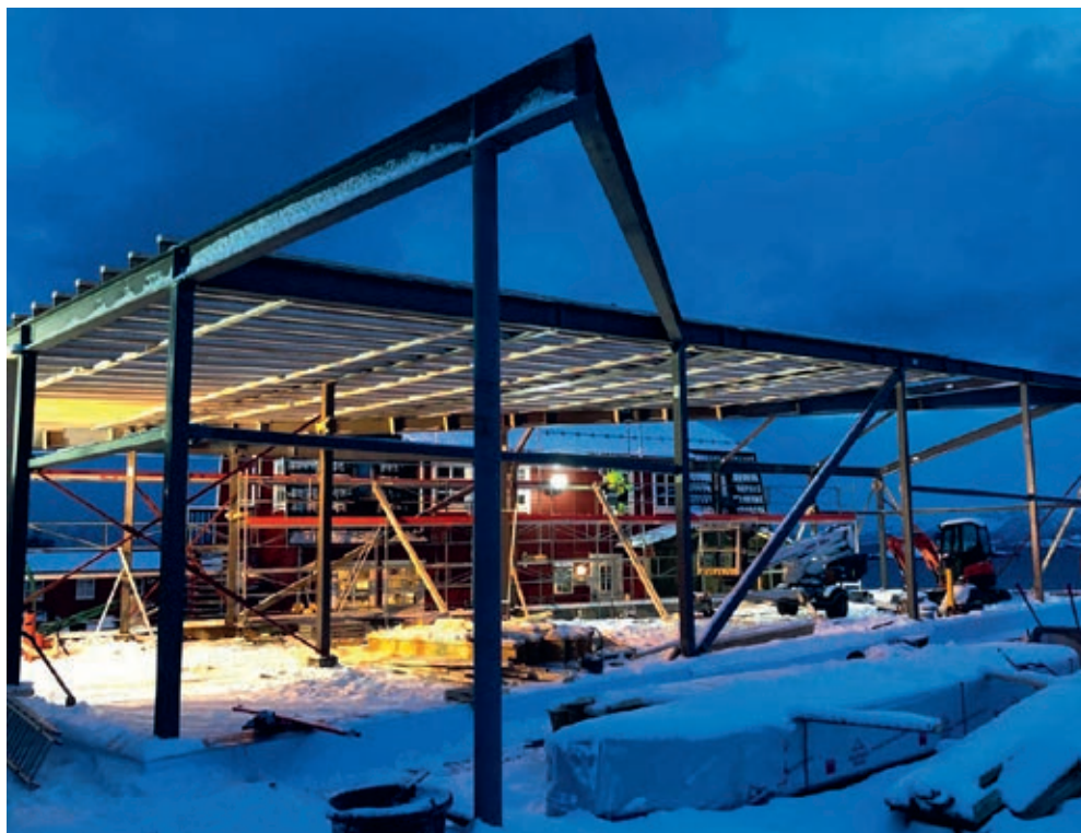
Restaurantbygget under oppføring
