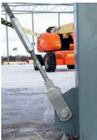
Infästning av dragstag i stålstommen.
