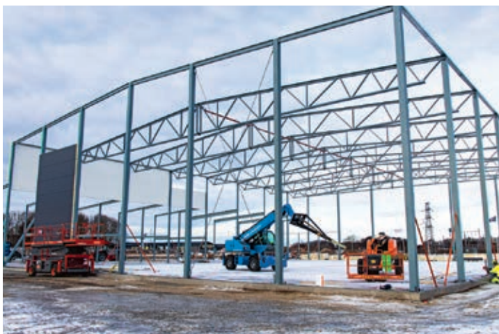
Stålstommen i väntan på att takplåten ska läggas.
