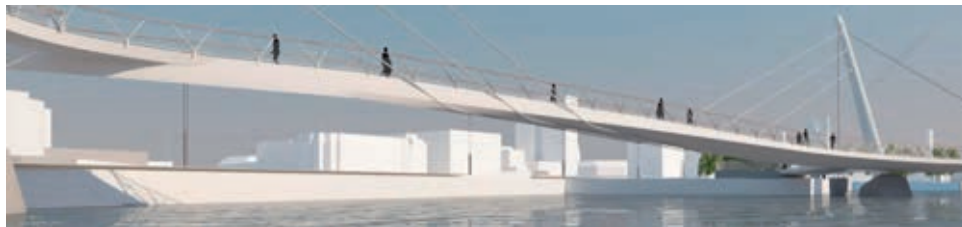
Bild 3. Illustrationen visar den unika lösningen med kablar som omsluter brobanan och "vagar" bron mellan pylonerna och därmed utgör en mix av en hängbro och en snedkabelbro.
