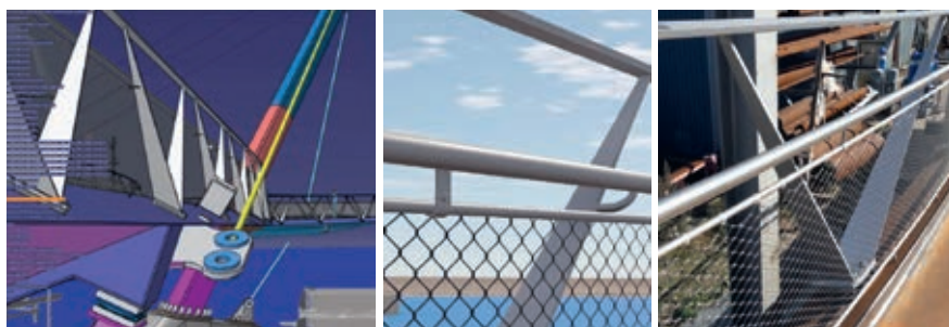
Bild 9. Räcke och infästningar för kablar har detaljutformats med hjälp av färgsatta, precist mått-satta modeller för att sedan studeras i mera realistiska, renderade bilder och i form av fullskalepro- typer som togs fram av PEAB/Stål & Rörmontage.
