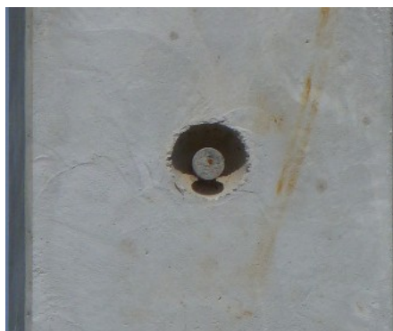
Anker istøbt beton klar til at løfte med Løftebeslag.
