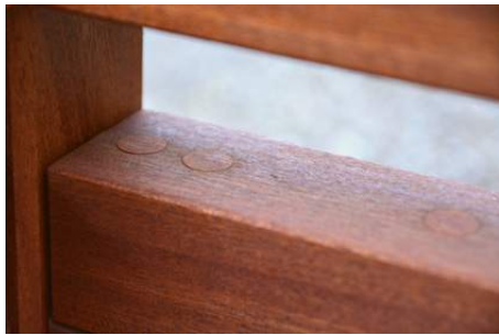
X-modul samlet med A4 skruer og proppet.
