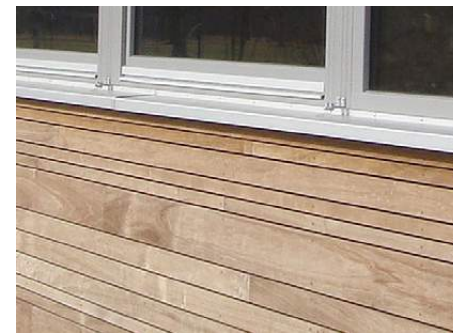
Termo træ kan anvendes på udsatte facader.
