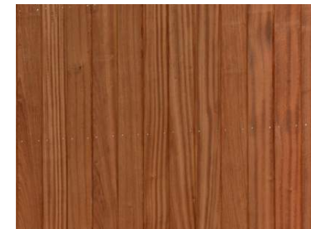
Profiler i mahogni opsat med rustfri skruer.
